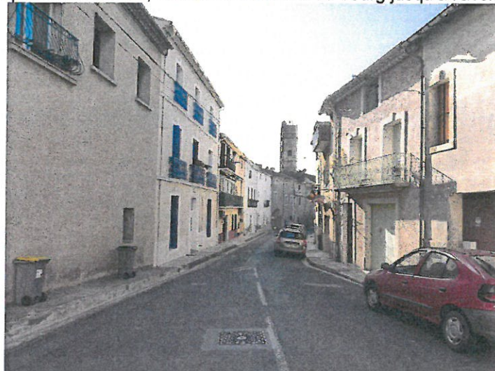
Photo 9 – Depuis l'extrémité Ouest de la rue neuve
