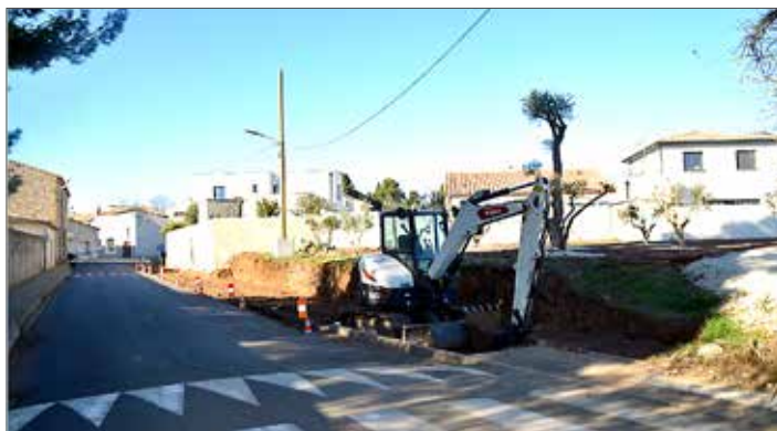
Le trottoir de la route de Marseillan , ainsi que le mur de soutènement, avant d'arriver à l'intersection de l'avenue des oliviers et du chemin du brougidoux est en cours de travaux.
