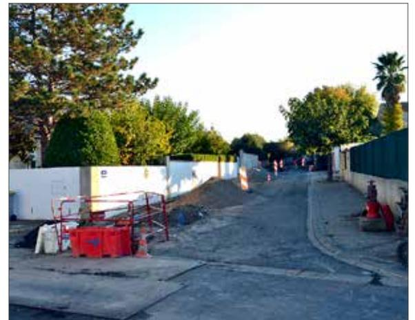
La rue du Carignan se refait une beauté avec le remplacement des réseaux humides (eau potable et assainissement), la création d'un réseau pluvial et la reprise des enrobés de chaussée et de trottoir. Ces travaux se font en partenariat avec la Communauté d'Agglomération Hérault Méditerranée et la participation du Département.
